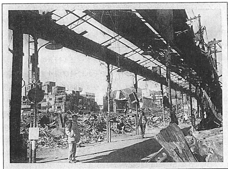
写真6 長田地区：アーケードの商店街が火災で跡形もない
